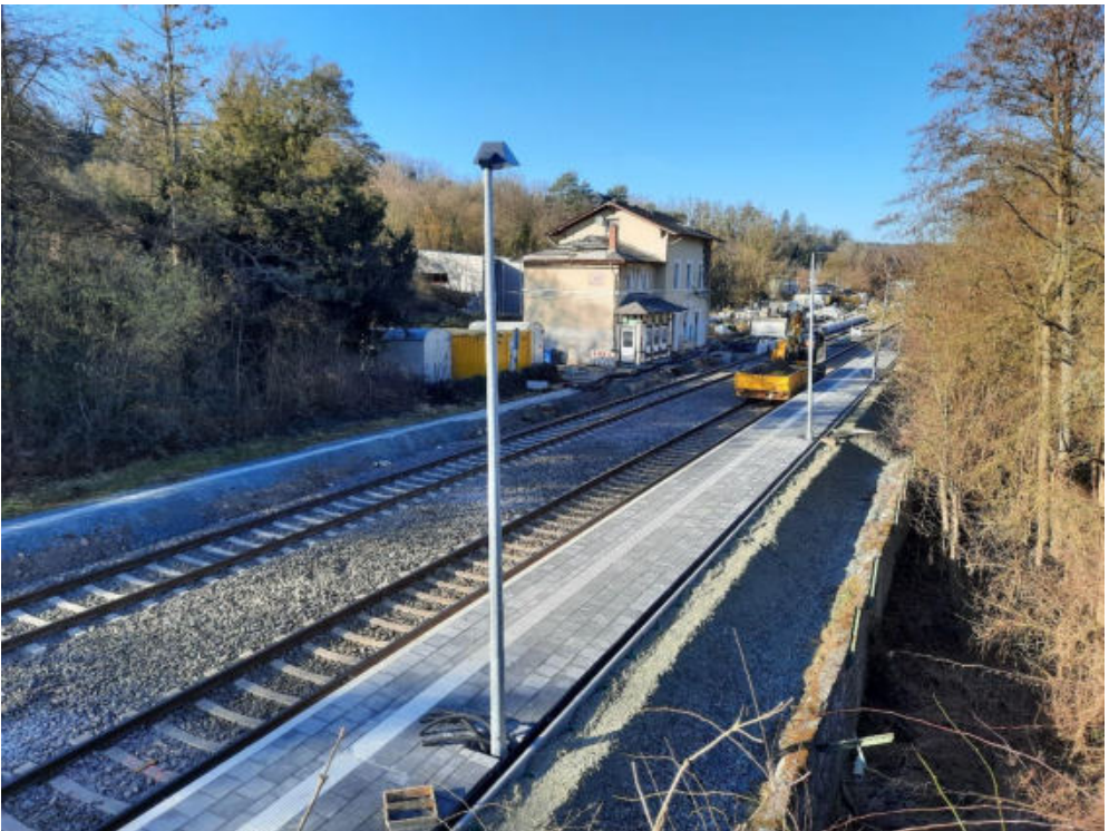
So sah es bei der Bahnstation Villmar Anfang März 2025 aus. Es ist ein Ende der Arbeiten abzusehen, jedoch fehlen noch zahlreiche Einrichtungen. Die Station liegt recht abseits von Villmar auf der anderen Lahnseite. Der Blick ist von der aus Marmor errichteten historischen Lahnbrücke. (Bild: Thomas Kraft)
